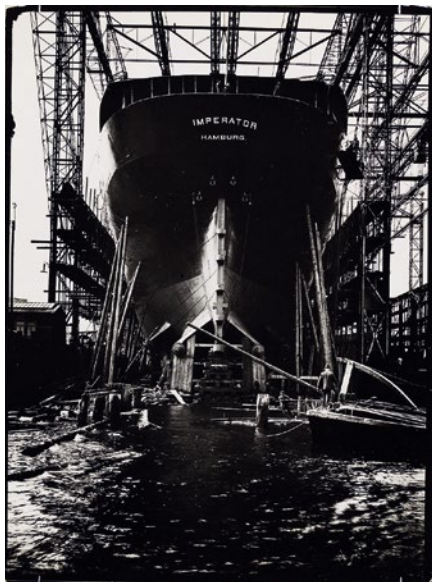
Der »Imperator« im Bau, Hamburg 20.5.1912.
