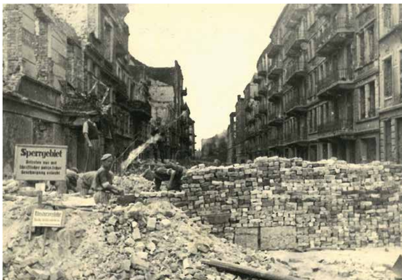
KZ-Häftlinge beim Bau einer Sperrmauer in der Gotenstraße in Hammerbrook, Sommer 1943. Quelle: Staatsarchiv Hamburg, Zeitgeschichtliche Sammlung, 731-06, I 18 A-1, Blatt 27, Mitte
